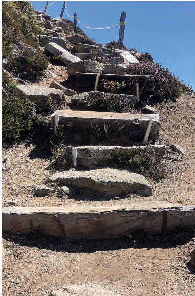
Göscheneralp: Der Weg ist steinig.
